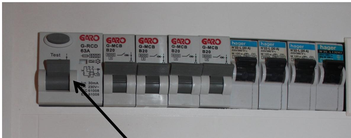
RCD Switch & Test button
